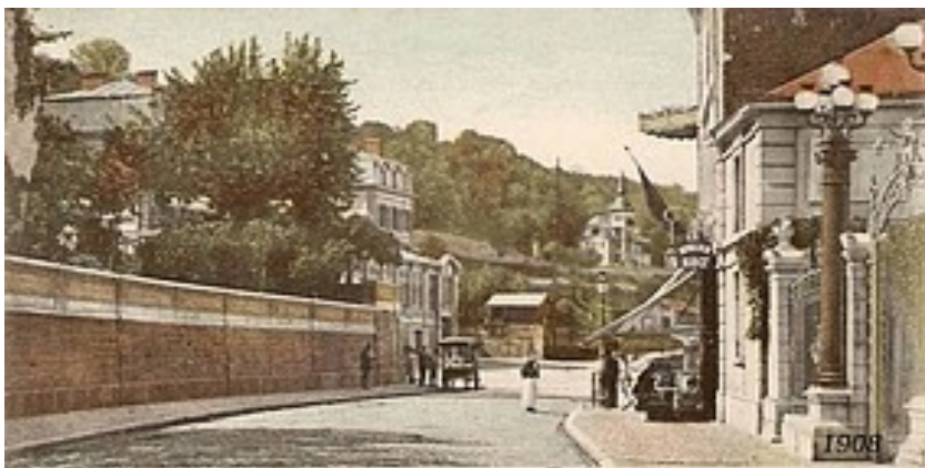
Le même endroit peu après : Le mur de briques a été rénové. À droite de l'image, on aperçoit l'élégante entrée de l'hôtel des Postes, rue de la Station.
